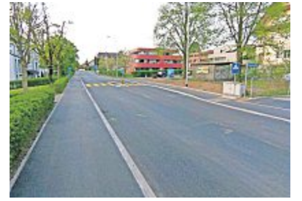
Die Sanierungsarbeiten der Holzhäusernstrasse befinden sich im Endspurt. z.V.g.
