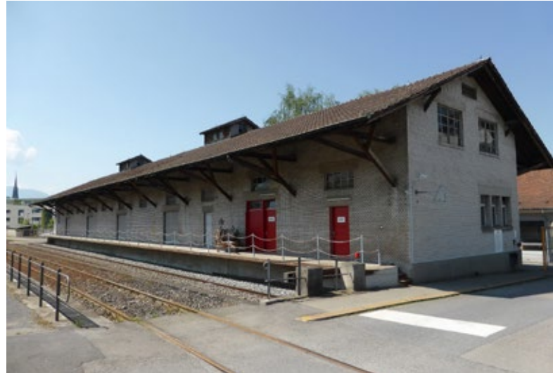
Ansicht Lagerhaus, Westfassade
